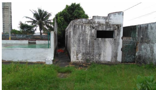
Imagem 03 – Vestiário Existente. Fonte: COPROJ-SEINF.
