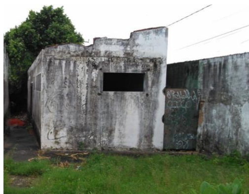
Imagem 11 – Foto tirada in loco da edificação de vestiário existente. Fonte: COPROJ-SEINF.
