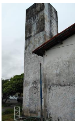
Imagem 10 – Foto tirada in loco da estrutura da caixa d'água e cisterna. Fonte: COPROJ-SEINF.
