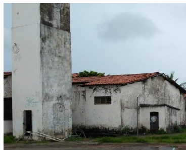
Imagem 05 – Acesso a Caixa D'água e Cisterna. Fonte: COPROJ-SEINF.
