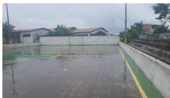
Imagem 03 - Foto tirada in loco quadra maior. Fonte: COPROJ-SEINF.
