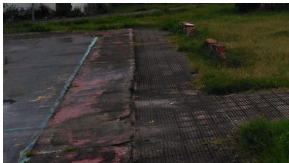
Imagem 04 – Desníveis da Circulação Entre as Quadras. Fonte: COPROJ-SEINF.
