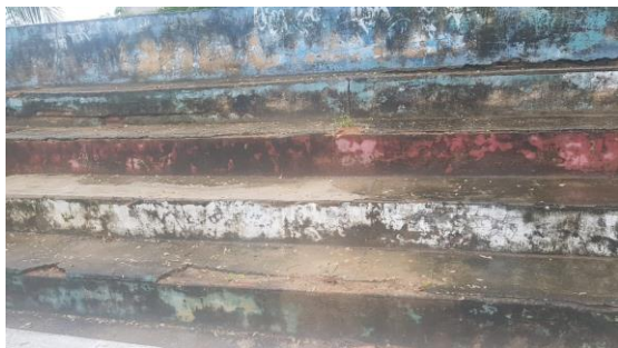
Imagem 06 – Foto tirada in loco arquibancada. Fonte: COPROJ-SEINF.
