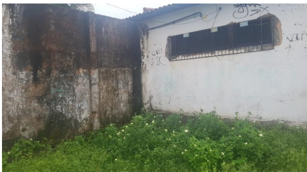
Imagem 18 – Foto tirada in loco próximo ao local onde se encontra a fossa. Fonte: COPROJ-SEINF.
